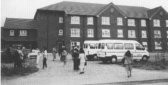
アンカーハウスの外観
