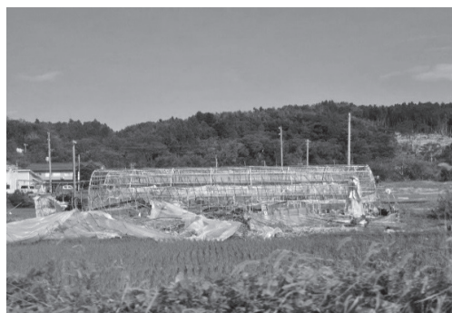
上総地区ハウス破損
