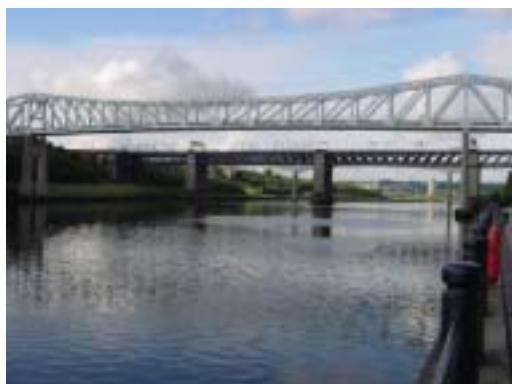
ニューキャッスル市内を流れるティン川 (Tyne River) にかかるティンブリッジ (Tyne Bridge)。ちなみにニューキャッスルの正式名は Newcastle upon Tyne。
